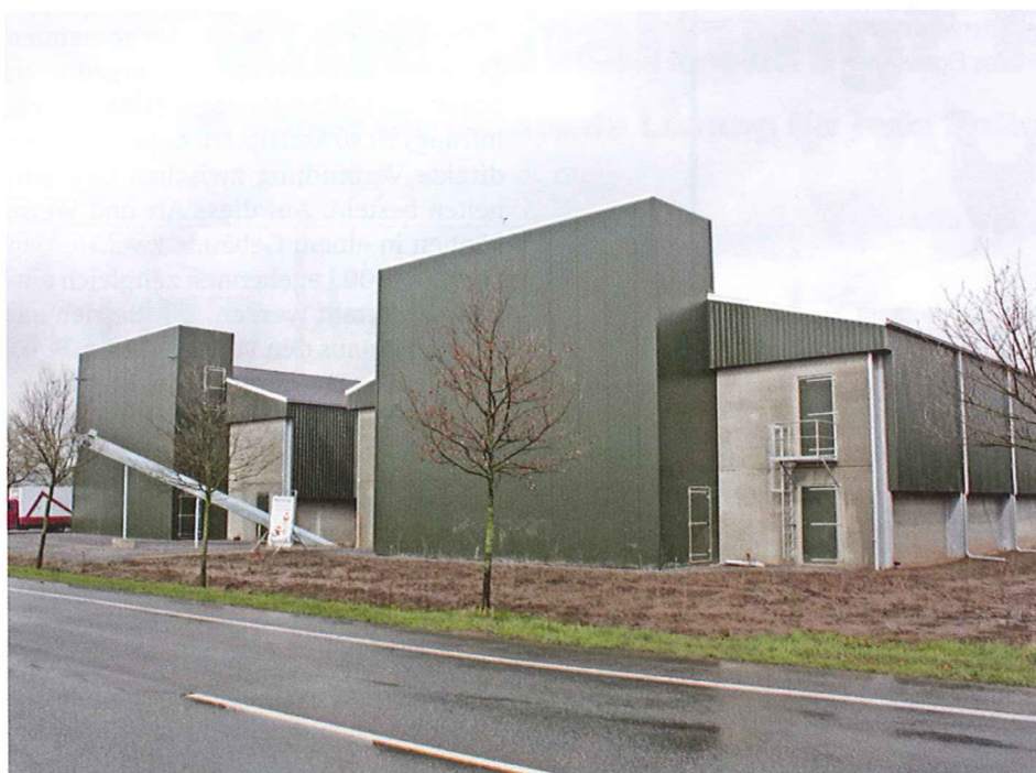
Die neuen Legehennenställe des Betriebes von Dietrich Vriesen liegen direkt an der Landstraße von Bocholt nach Dinxperlo.
